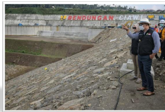
Bendungan Ciawi yang Mengering pada Tahun 2022 – jabarprov.go.id
