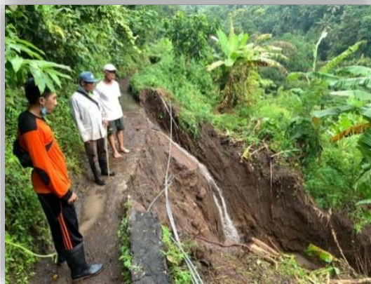
Tanah Longsor di Kabupaten Buleleng – bpbd.bulelengkab.go.id
